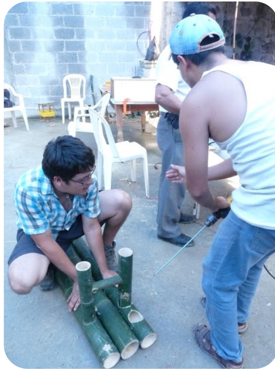
Unión del asiento de la banca con espárrago metálico.
